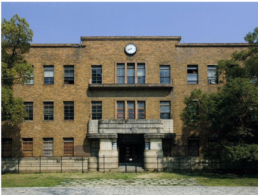
広島大学旧理学部1号館玄関周辺
